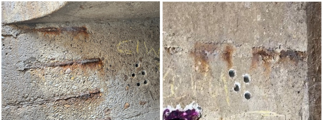
Bild 2: Beispiele für freiliegende, korrodierte Bewehrungsstäbe an Wänden
