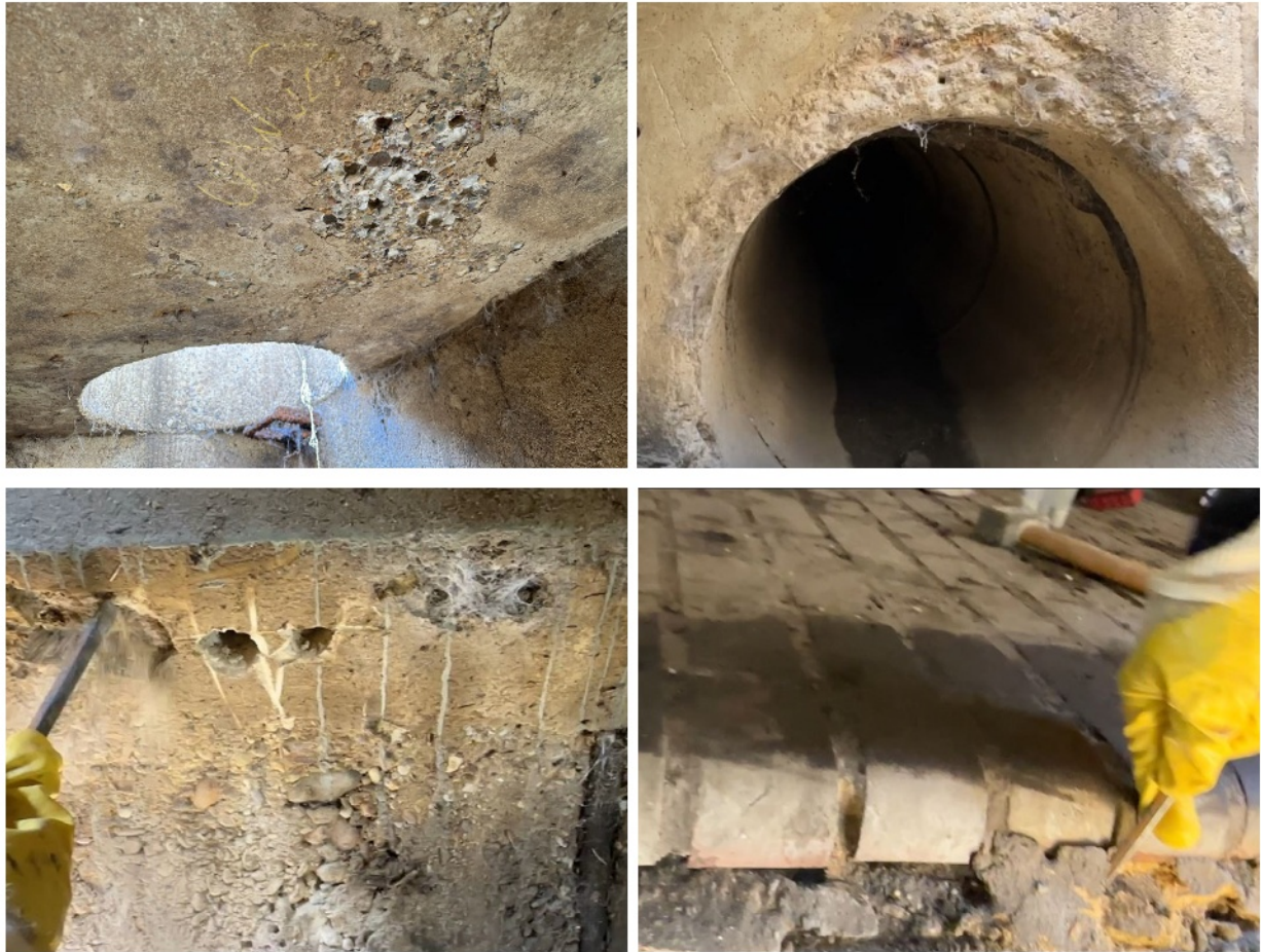
Bild 1: Beispiele für minderfesten bzw. weichen Beton bzw. Mörtel
