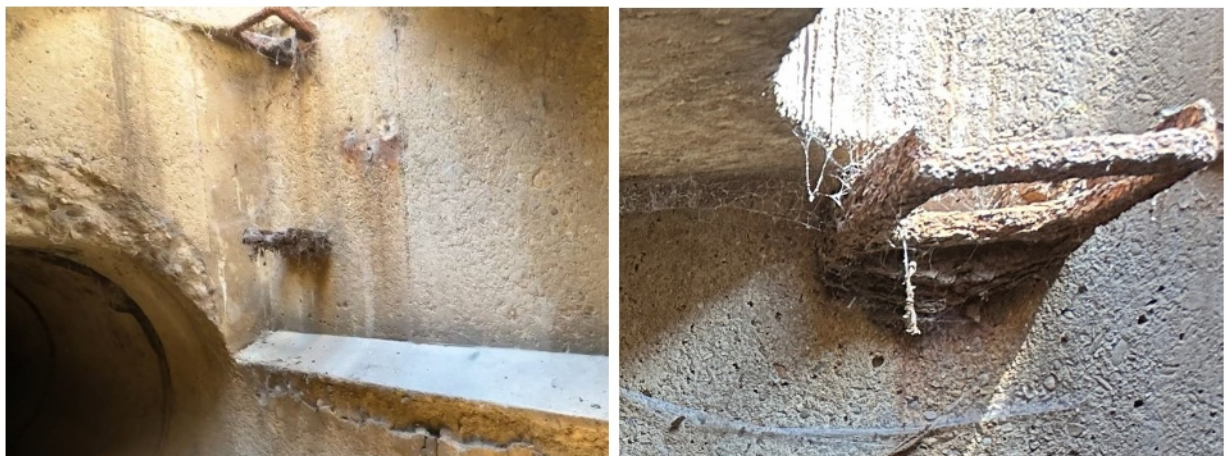
Bild 3: Beispiele für korrodierte Steigeisen bei den Einstiegen
