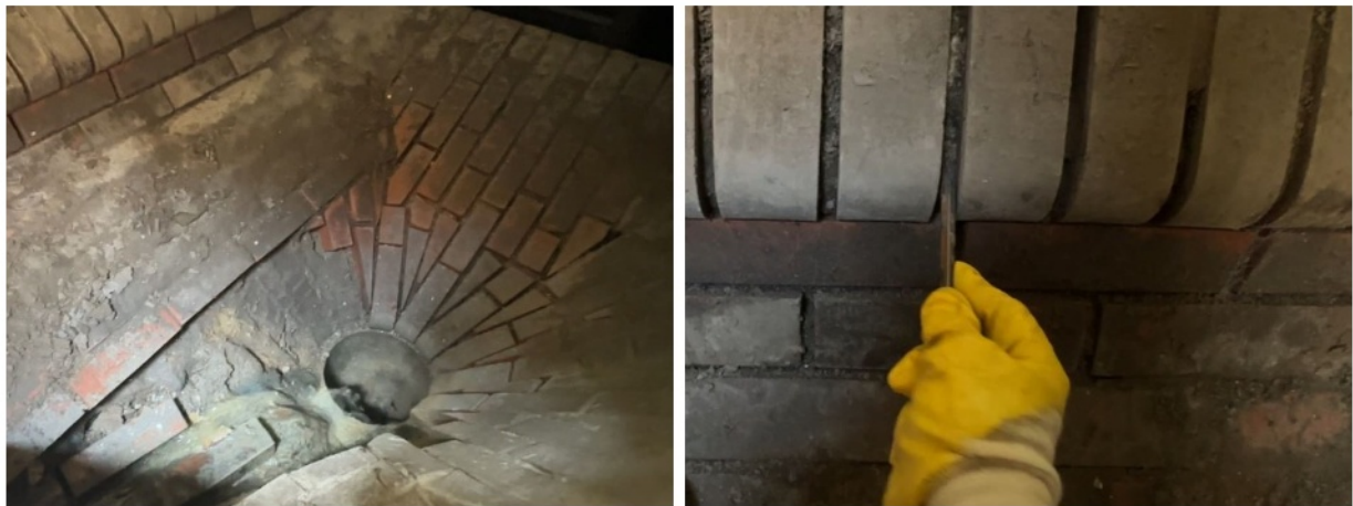
Bild 4: Beispiele für intakten Kanalklinker mit brüchigem Fugen- / Bettungsmörtel
