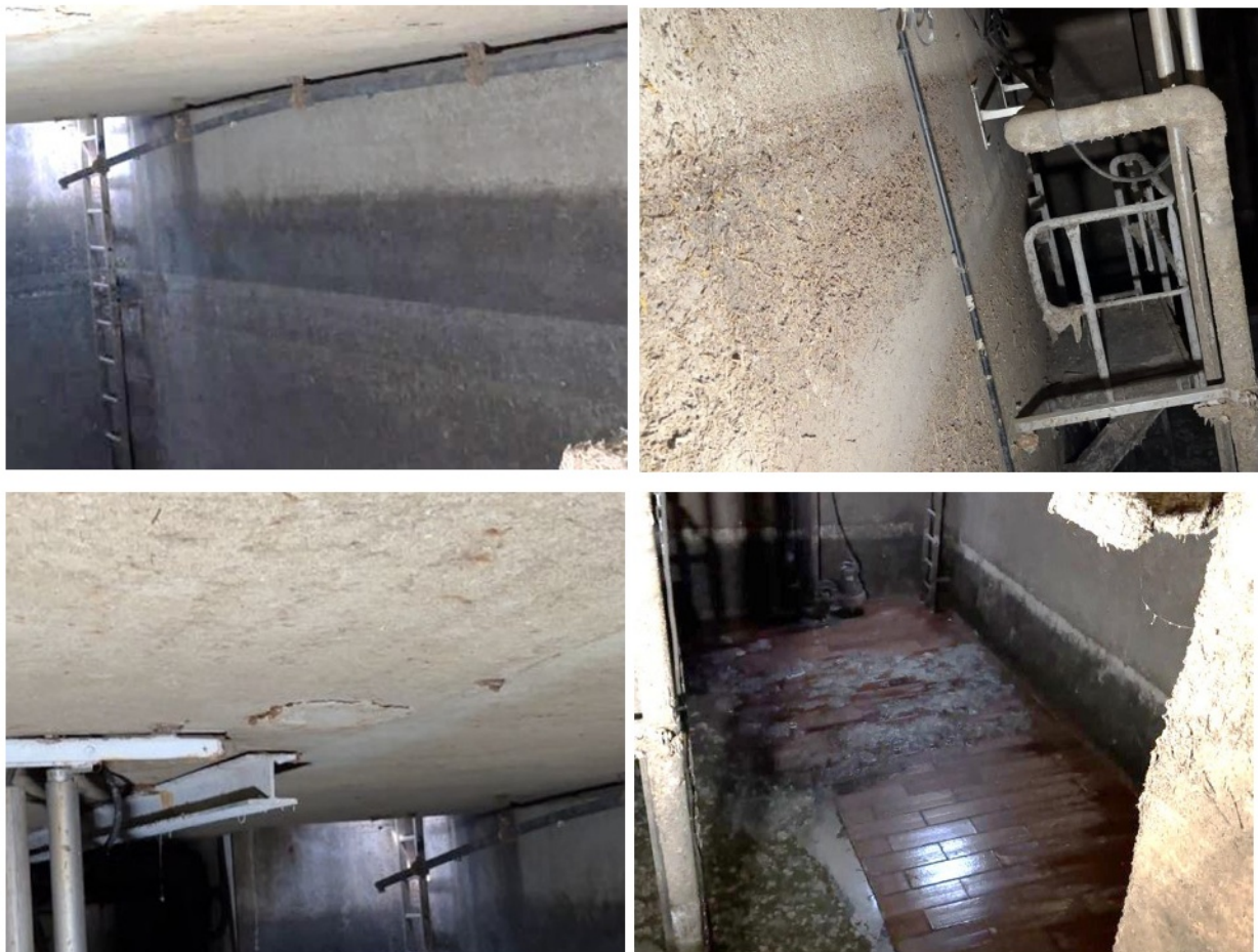
Bild 5: Beispiele für Schmutzablagerungen an Wänden (oben), eine Abplatzung an der Deckenuntersicht (unten links) und lokal zerstörte Kanalklinkerbereiche am Boden (unten rechts) der Reinigungsanlage
